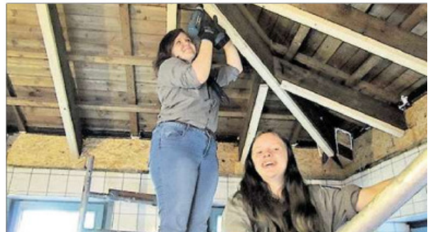
„Selbst ist die Devise“ während der intensiven Bauwoche.
