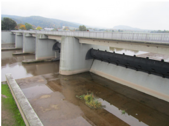
Leine-Rückhaltebecken in Salzderhelden
